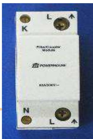
Este filtro se utiliza para filtrar las señales de entrada y de salida del sistema X-10 para que otro usuario no influya en nuestra instalación y nosotros en la del otro usuario.
